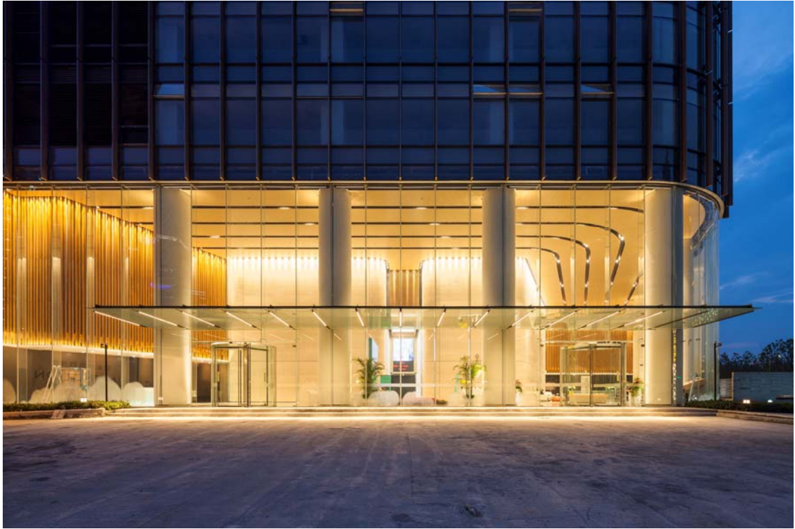
エントランス側外観
