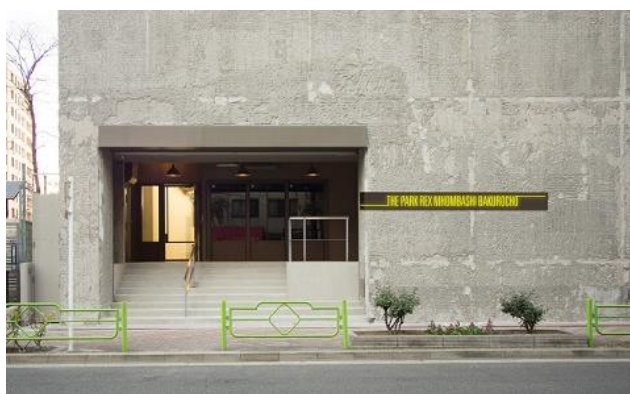
エントランス（リノベーション後）
