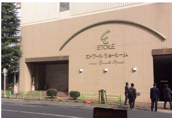
エントランス（リノベーション前）
