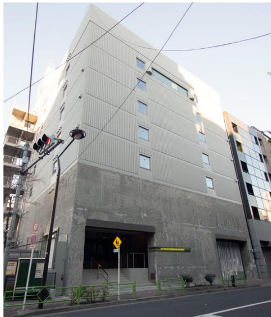
▲「ザ・パークレックス 日本橋馬喰町」外観写真
