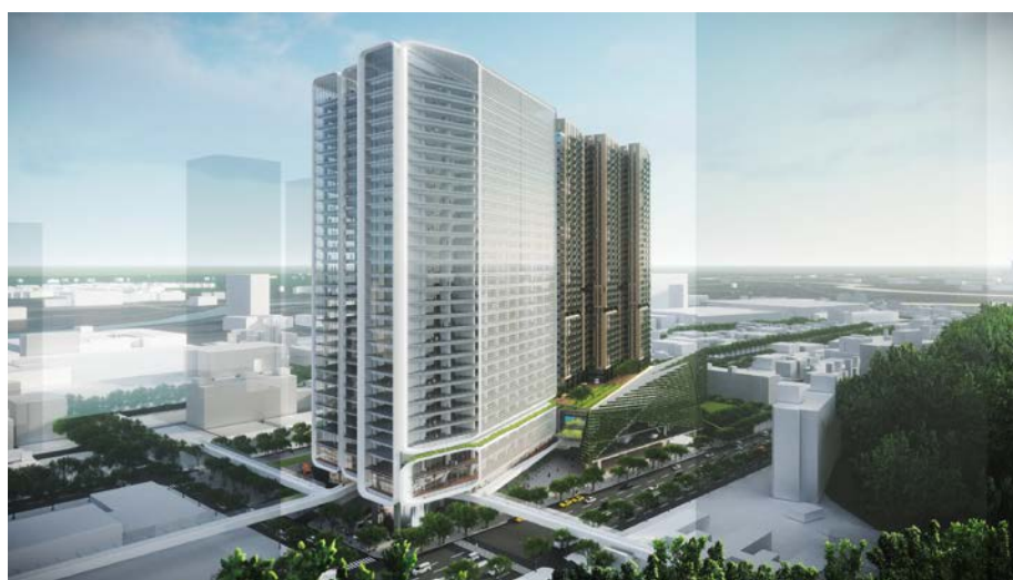
南側外観：手前がオフィス棟 奥が住宅棟
