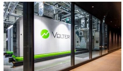
再生可能エネルギーの積極的な利用と、システムの高効率化への改善を重ね、発電量を加味するとオフィス棟では運用時のCO2排出量は年間でマイナス159トンとなり、完全なCO2排出量ゼロを実現しました。また、地下水熱・バイオマス CHPを利用した熱源システムは、CO2だけでなくフロンガス使用量も削減。環境負荷を最小限としています。
