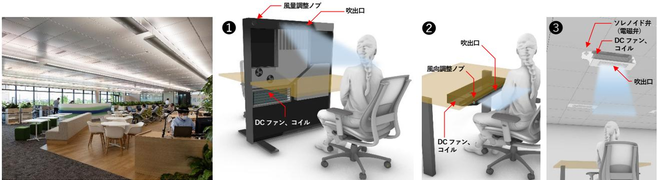
執務フロア。システム天井対応放射パネルを採用。平滑面に照明を反射させ、部屋の明るさ感の向上にも寄与する。
