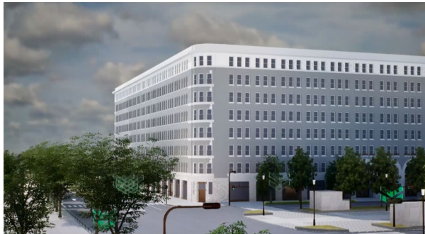
震災復興（震災後）の姿。外壁はタイルからモルタル仕上げに。
