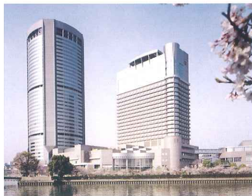
所在地:大阪市北区、設備規模:冷水5000RT/温水9380Mcal
