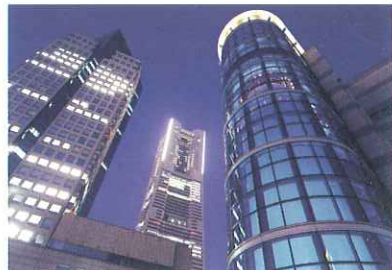
みなとみらい21熱供給センタープラント
