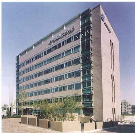
所在地:神戸市中央区、規模:地上8階/塔屋1階、延床面積:10,689m 2
